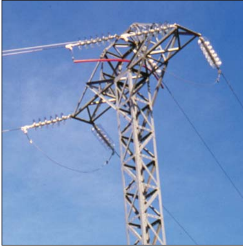
Foto 35. Colocación de mayor número de discos aisladores y aislamiento del cable central.
