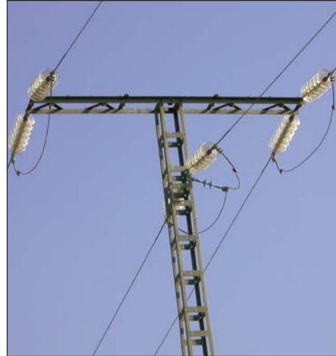
Foto 36. Colocación del cable central por debajo de la cruceta e incremento en el número de discos aisladores..
